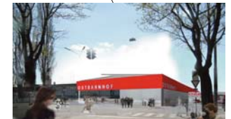
Der provisorische Wien Südbahnhof (Ostbahn) ist ab 13. Dezember Ausgangs- und Endbahnhof für Züge des Nah- und Regionalverkehrs der Ostbahn und der S60.
