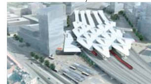
In den kommenden Jahren werden eine moderne Verkehrsdrehscheibe und ein neues Stadtviertel – das Projekt Hauptbahnhof Wien – errichtet.
